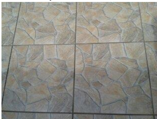
Figura 4 – Vedado o uso de cerâmica nos passeios.
