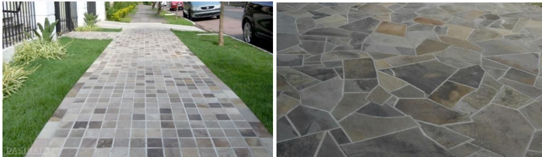
Figura 3- Construção de passeio com pedras.
